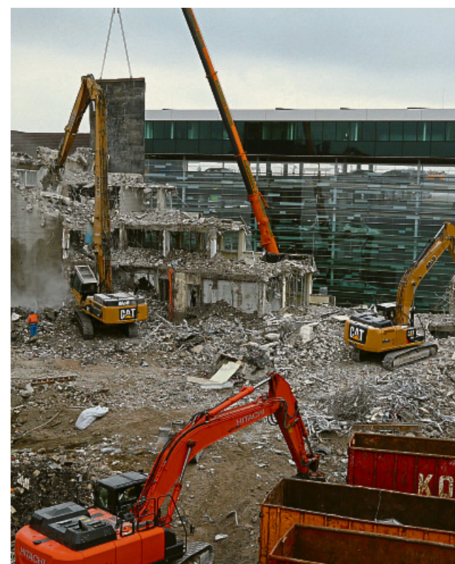
Der massive Treppenturm (l.) des Ex-Hotels an der Ecke Herwarthstraße/Achtermannstraße sorgte dafür, dass die Abbrucharbeiten länger als geplant dauern. Foto: Oliver Werner
